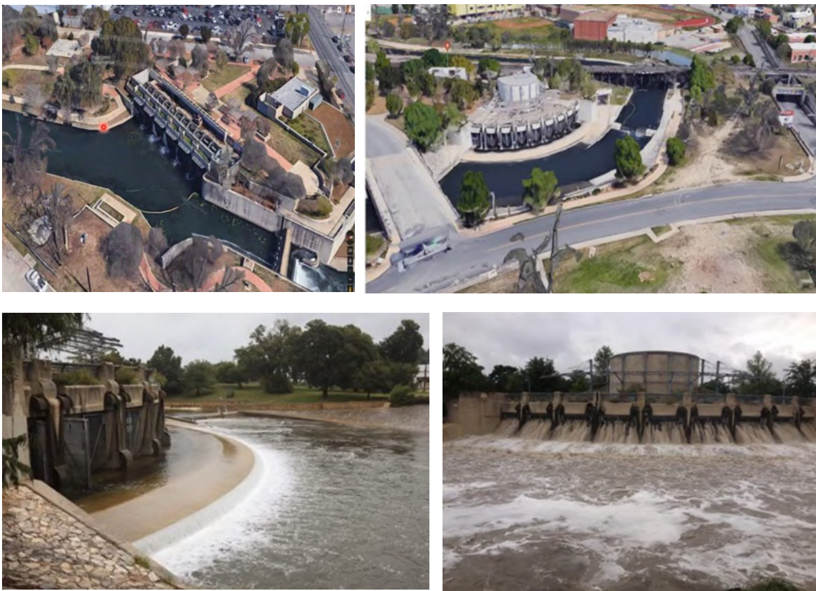
Figura 21. Estructuras de entrada y de salida del Túnel del Río San Antonio. En la de salida, abajo, se aprecian los flujos normales y bajo altos caudales [10]
