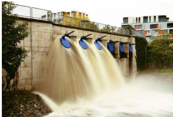
Figura 13 Estación de bombeo de la corriente Rokytká en Praga [6]
