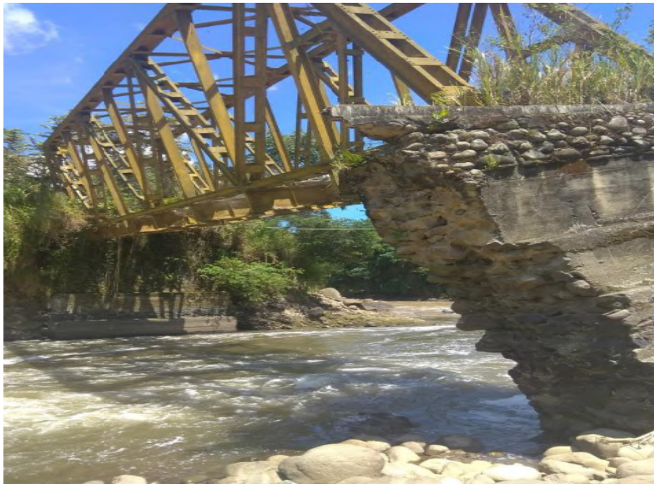
Figura 1. Vista Norte de aproches del corredor ferroviario del Pacífico al puente sobre el Río Cauca en inmediaciones de Cali, Valle del Cauca, más de 6 años de abandono.
